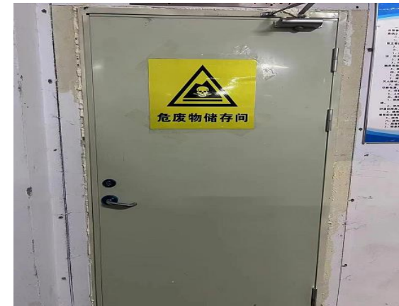
项目危险废物暂存间
